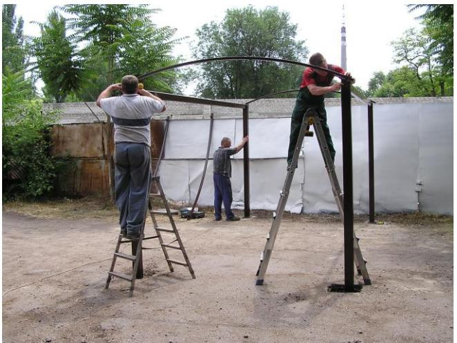
Установить несущие балки на стойки.
