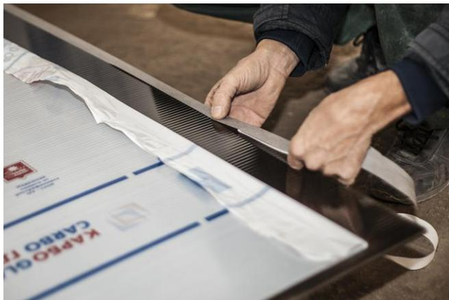
Заклеить торцы сотового поликарбонатного листа перфорированной лентой.
