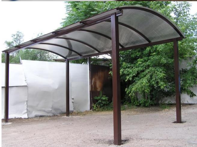
Закрепить лист на каркасе саморезами с термошайбами. Можно предварительно просверлить отверстия в арках.
