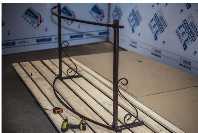
Установить арки в кронштейны, закрепив их в уголках 4-мя болтами М6\*50.
