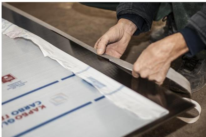
Заклеить торцы сотового поликарбонатного листа перфорированной лентой.
