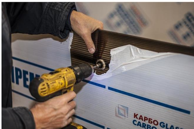
Надеть на торцы листа торцевой алюминиевый профиль, предварительно просверлив в нём дренажные отверстия 3-4мм, с шагом 250 мм под выступом капельника.
